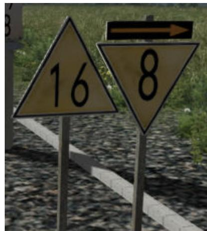
Lf 7 **“Geschwindigkeitstafel”** Die am Signal angezeigte Geschwindigkeit (Zahl x 10) darf ab diesem Signal nicht mehr überschritten werden.
